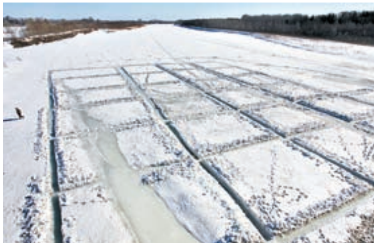
Распилы льда производят вблизи мостовых опор.
