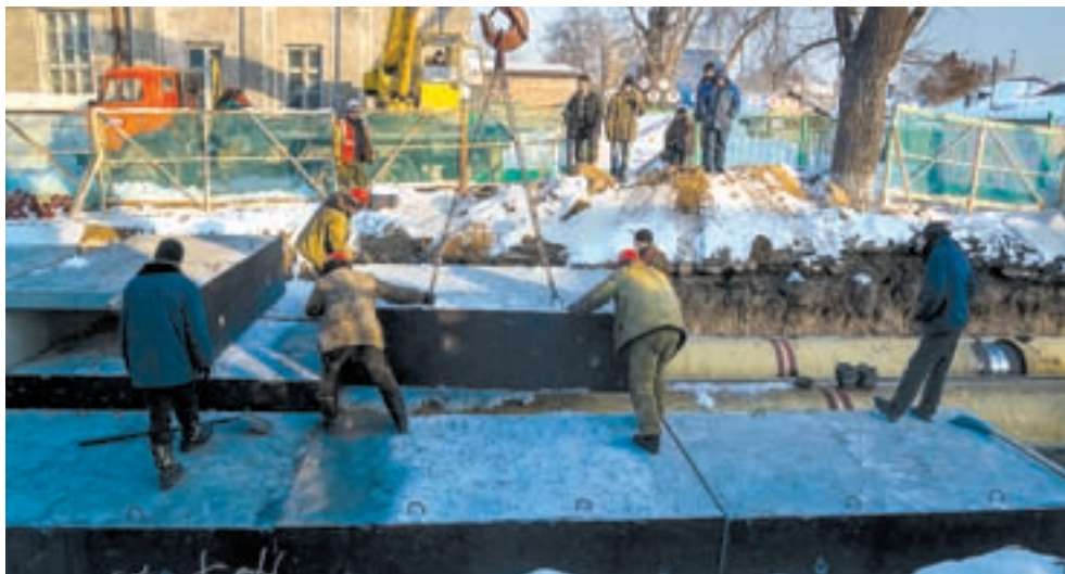
Строительство переемычки завершится к маю.
