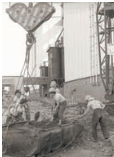
Линейный строительный студенческий отряд «Монолит» Алтайского государственного медицинского института возводит элеватор в Камень-на-Оби. 1978 год.
