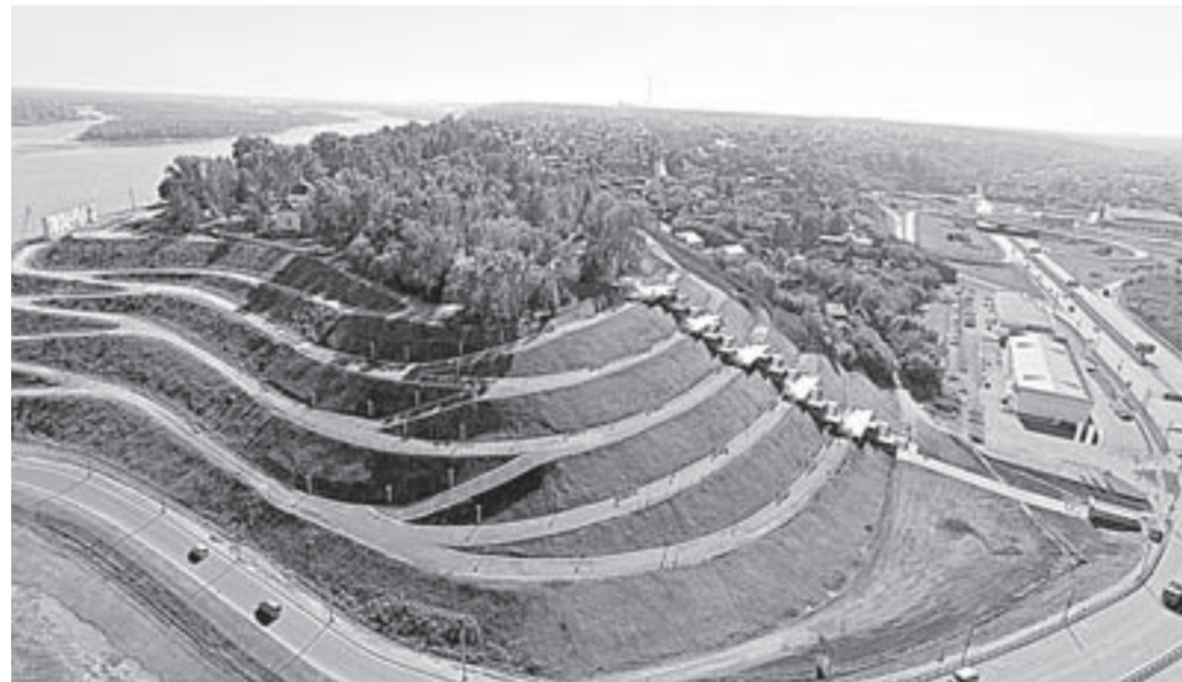
Комплекс «Нагорный парк». Террасирование склонов парка с водоотведением.
