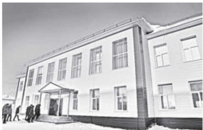
Так после капитального ремонта выглядит начальная школа.
