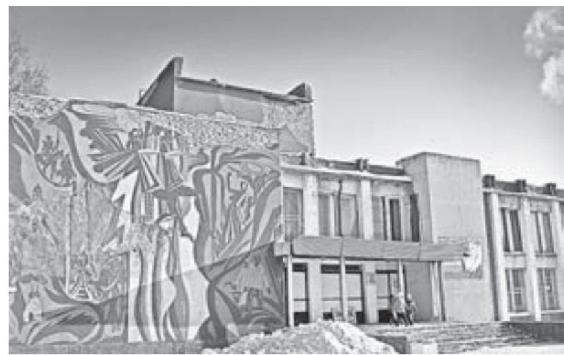
Ремонт Усть-Пристанского районного Дома культуры начнется в 2017 г.
