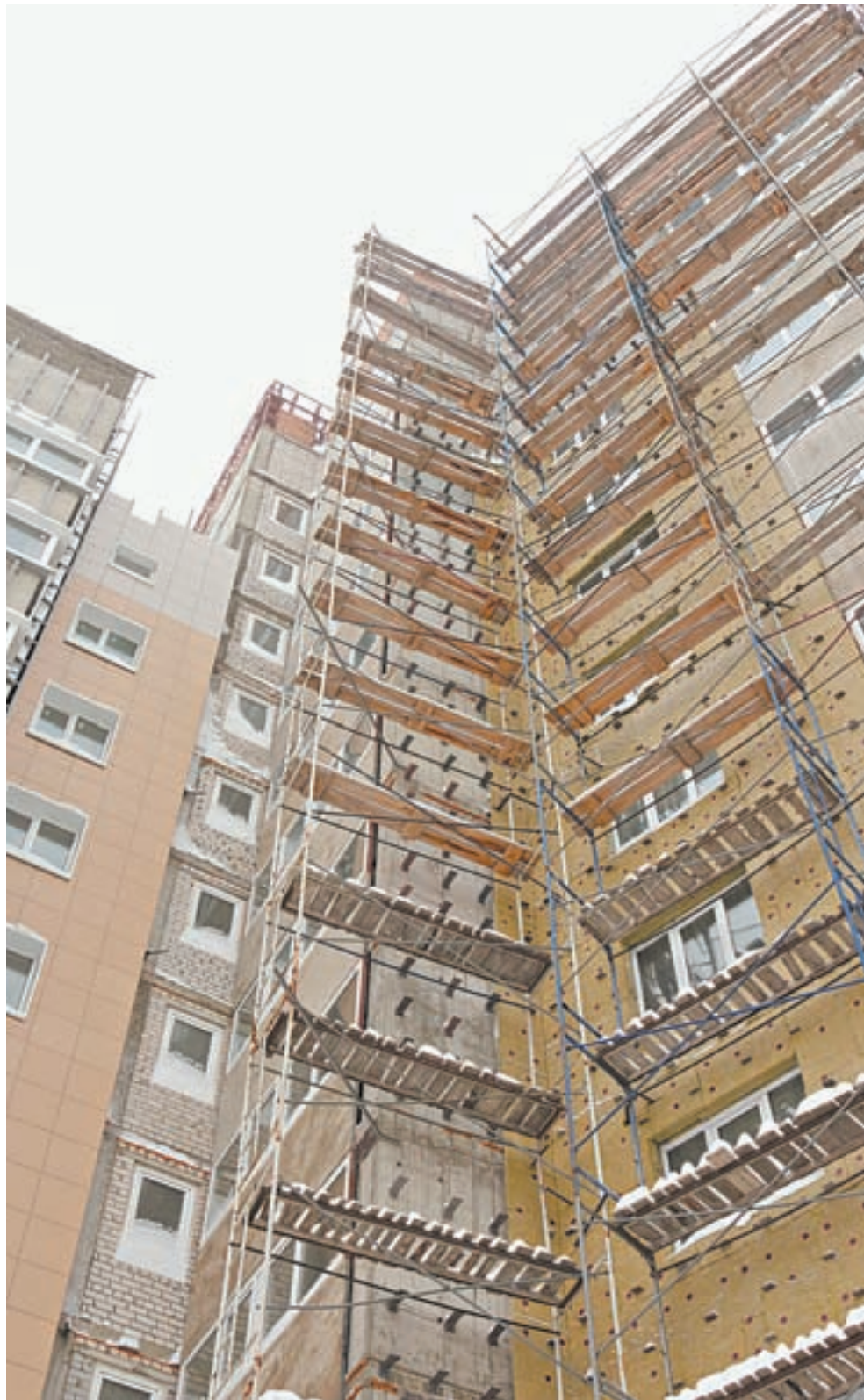
Работы на ул. Антона Петрова, 254 не ведутся уже год.
