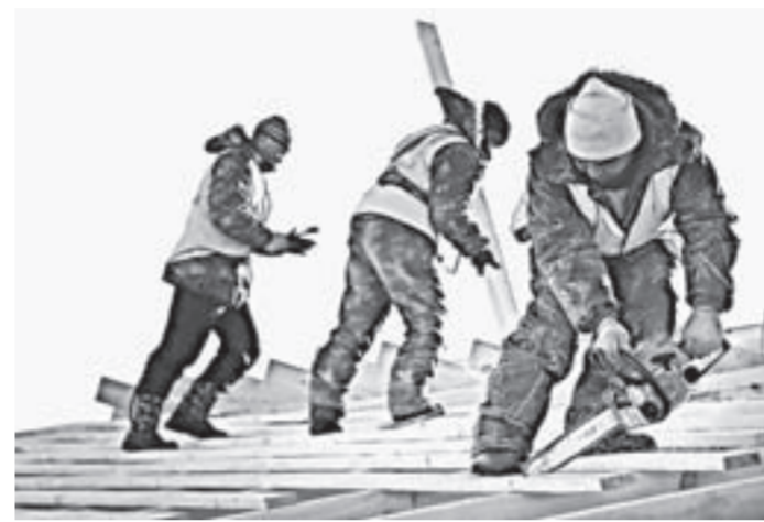
Эта крыша больше течь не будет.
