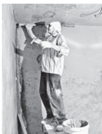
В корпусах уже ведется внутренняя отделка.
