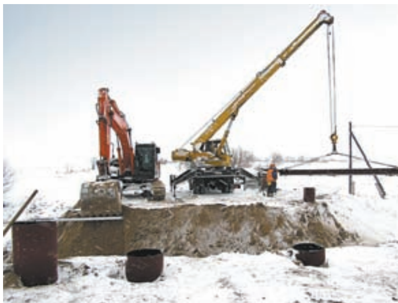
Начальная стадия работ.
