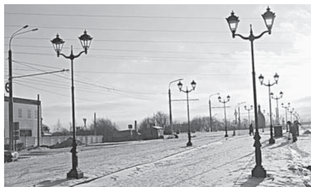
Со стройплощадки уже убрали ограждение и можно любоваться обновленной мостовой.
