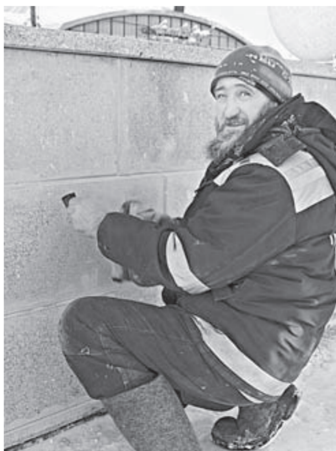
Рабочие очищают от снега и льда пролеты моста.
