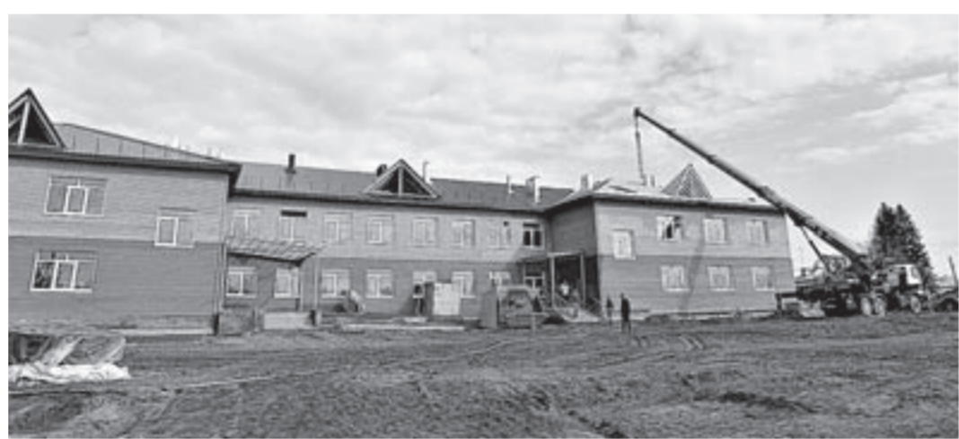
В 2017 году работы будут сосредоточены на продолжающихся стройках.
