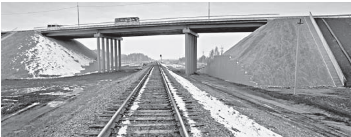
Длина путепровода – 65 метров.
