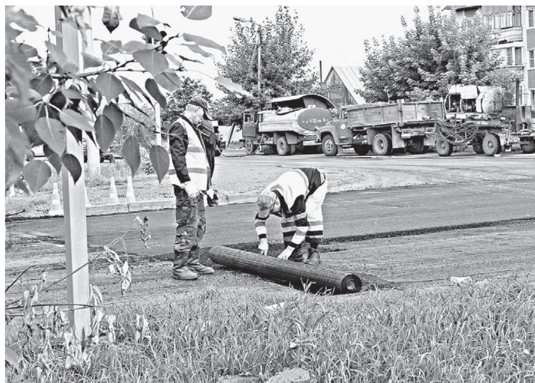
Укладна геосетки для устройства прочного дорожного покрытия.
