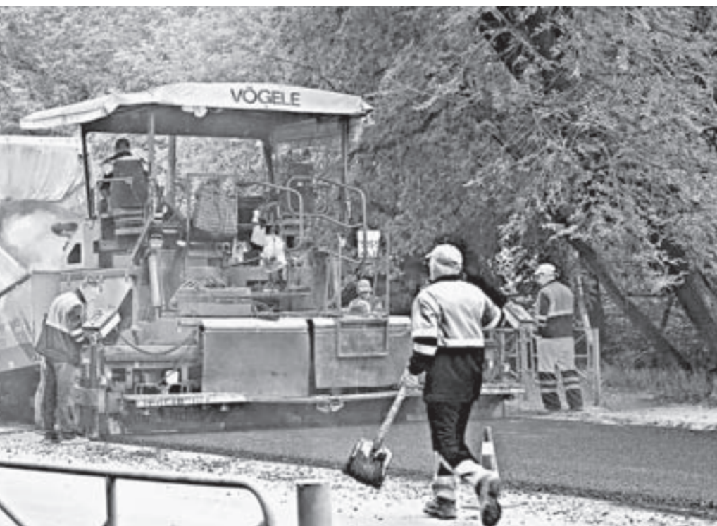
В дорожном ремонте задействован современный асфальтоукладчик.
