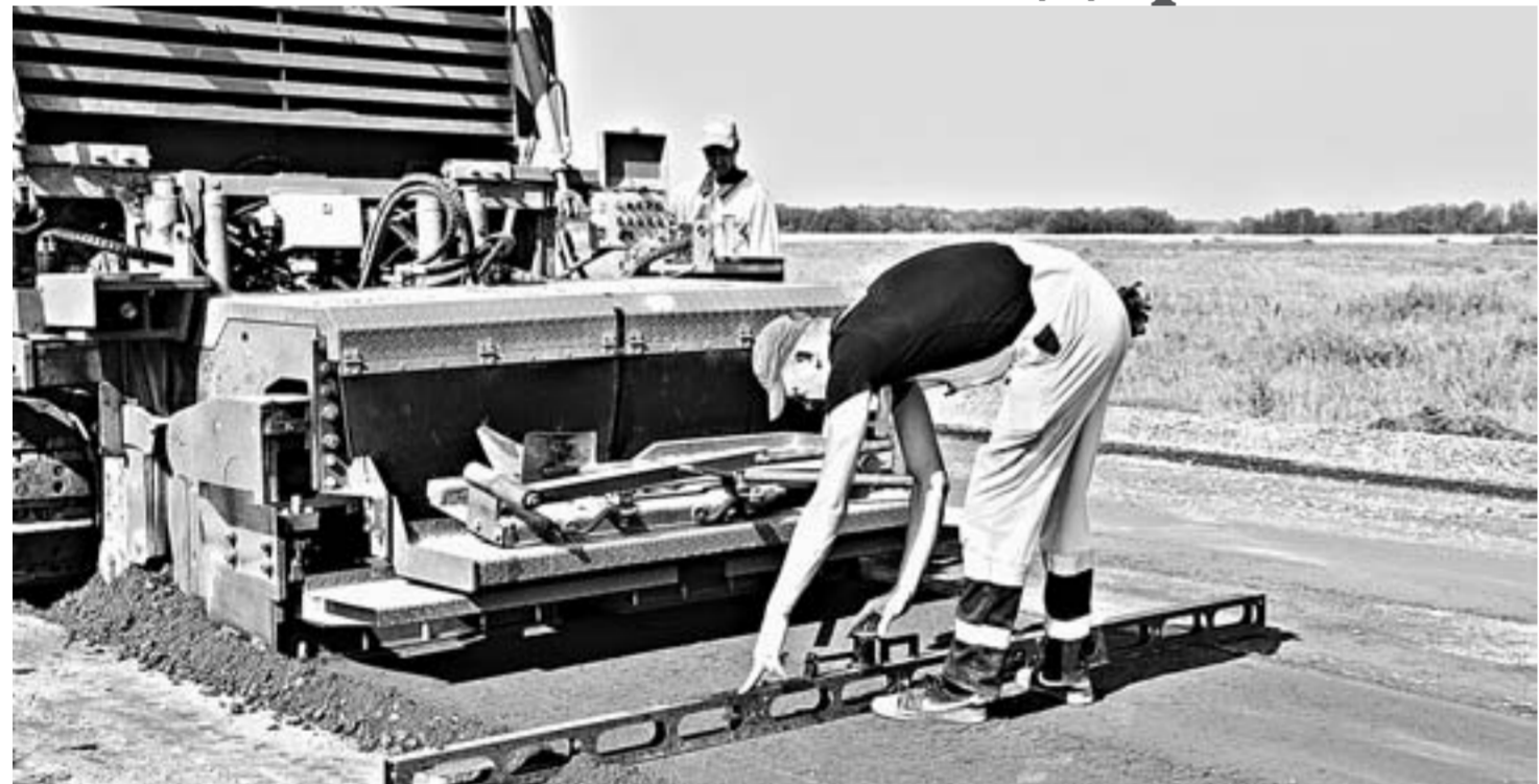
Рабочий проверяет горизонтальность свежего слоя дорожного полотна.
