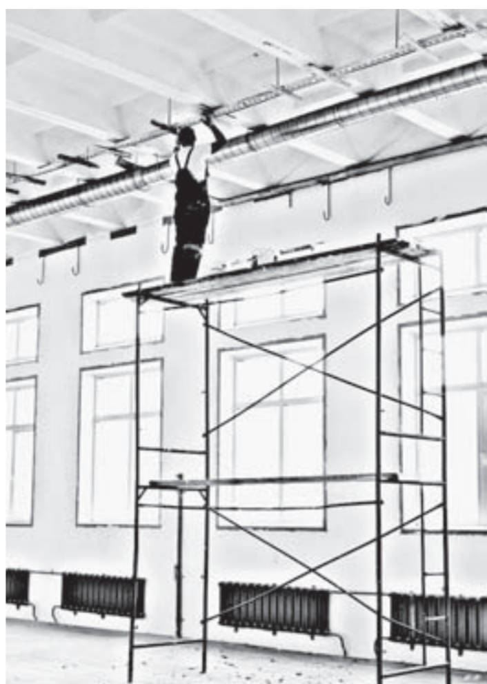
Ремонт лицей близится к концу.
