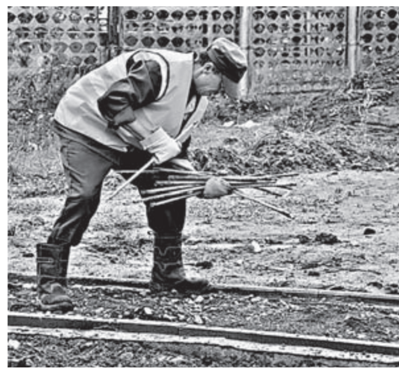
Здесь будет тротуар.
