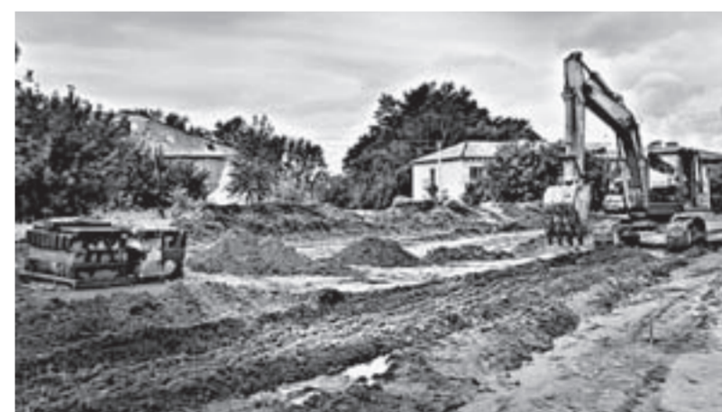
Пока идет устройство насыпи.
