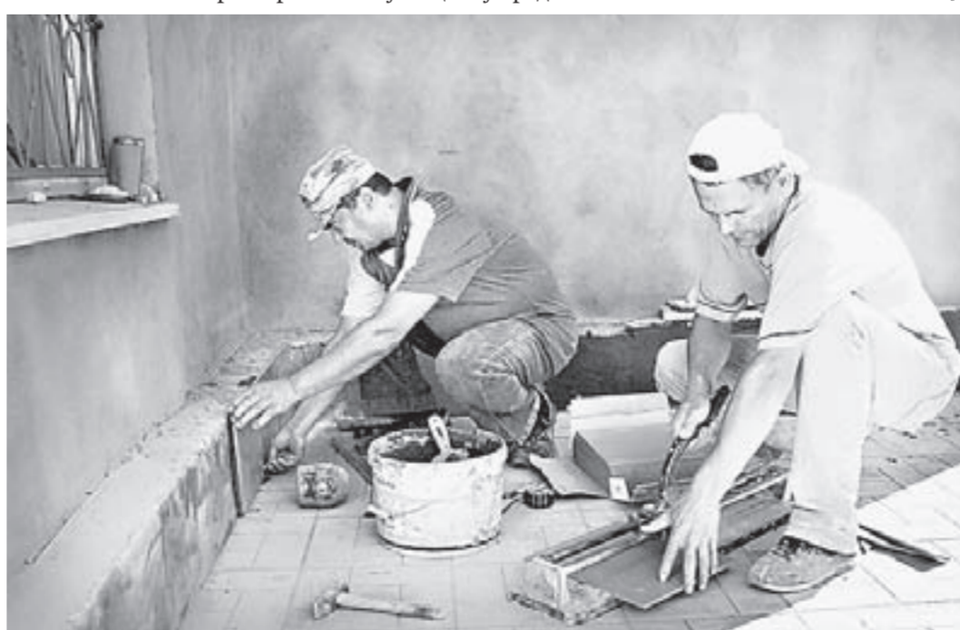
Сейчас в поликлинике идет ремонт.
