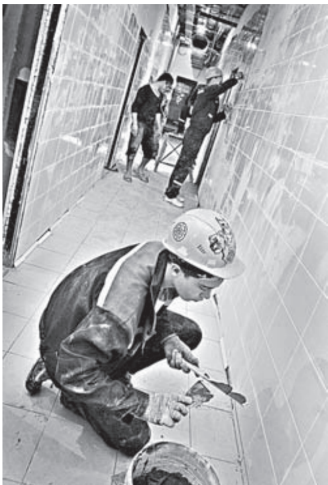
Работы близятся к завершению.
