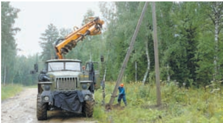
Энергетики заменили свыше полутора тысяч опор.
