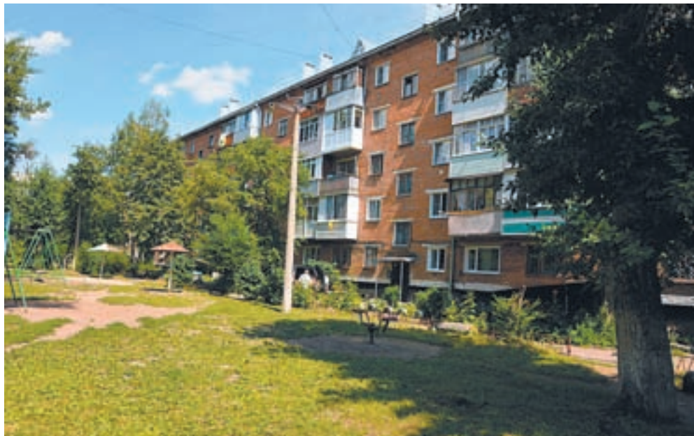
В Рубцовске запланировано отремонтировать около 40 домов.
