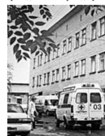
С помощью «Агро-Стандарта» будет отремонтирован операционный блок больницы.
