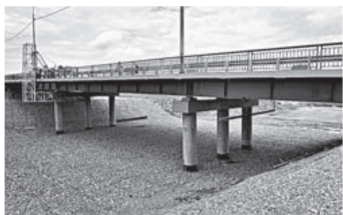
Мост через реку Клепечиху уже готов к сдаче.
