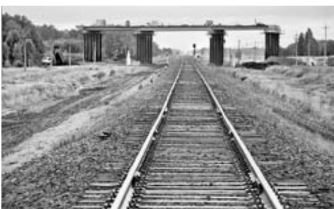
Путепровод на трассе Павловск-Ребриха-Буканское. Работы продолжаются.
