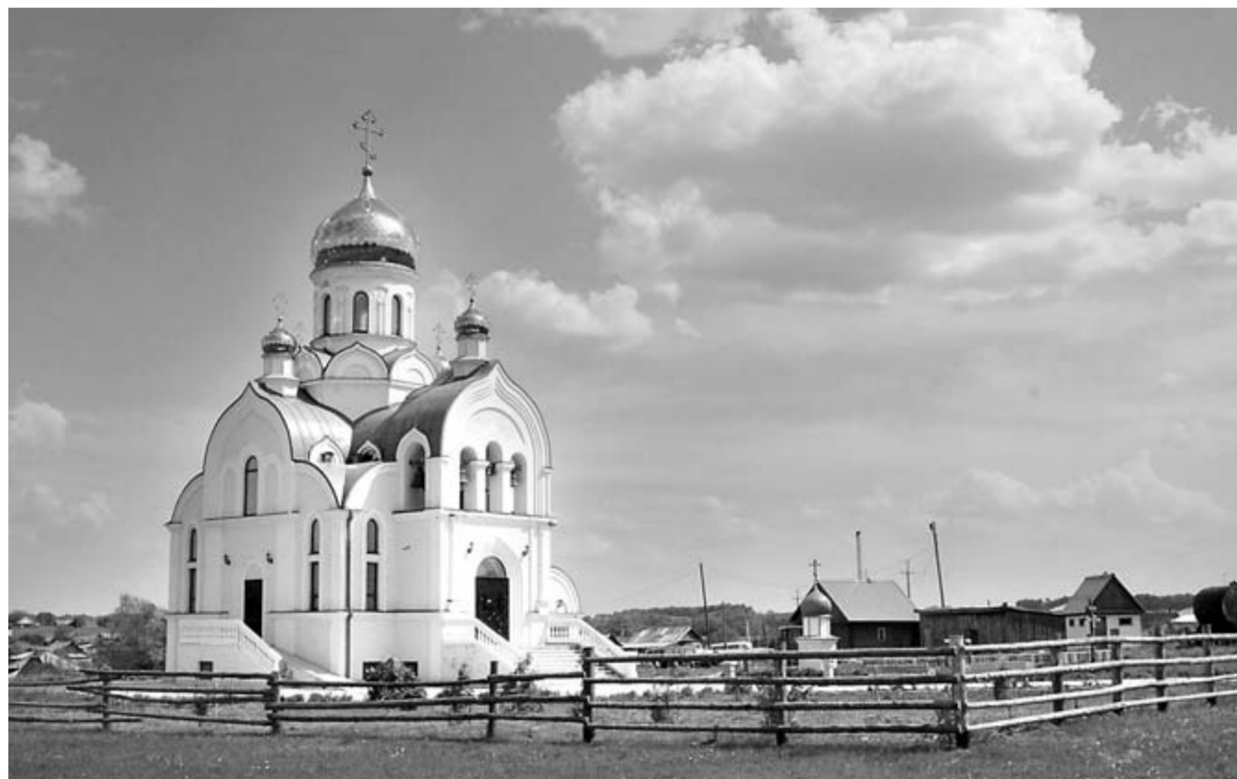
Новый храм Архангела Михаила построен по проекту Татьяны Дьяковой (мастерская Петра Анисифорова).
