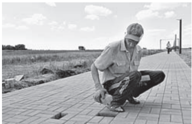
Рабочим надо уложить 2 тысячи квадратов тротуарной плитки.
