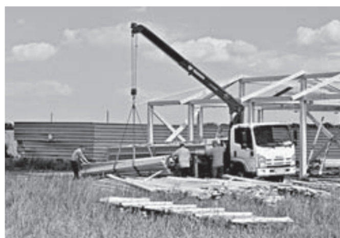
Строительство вольеров для скота в разгаре.
