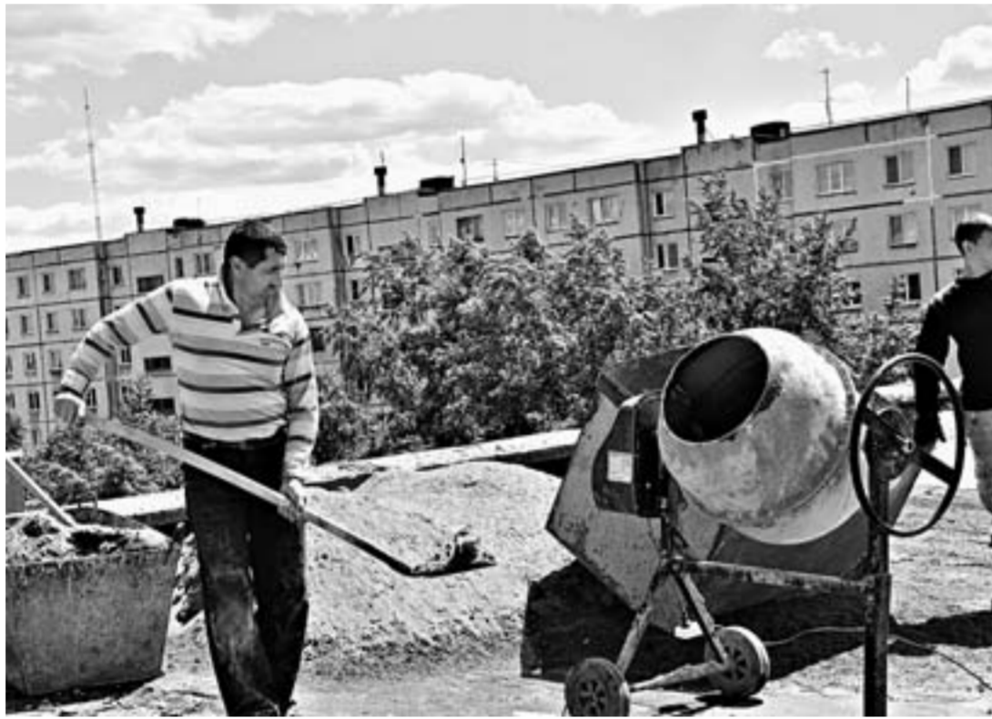
Через два месяца работы завершатся.
