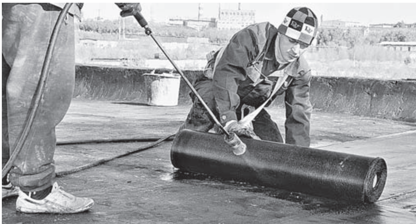
Раскатывать рулоны кровельного материала нужно в сухую погоду.
