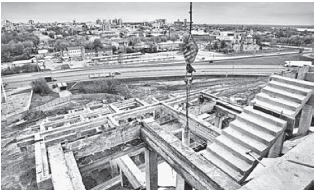
Каркас лестницы уже готов.
