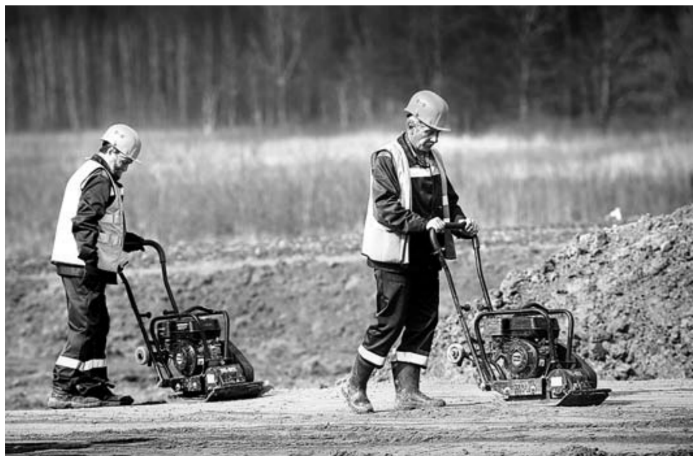
Дорожники работают на новом объекте очень оперативно.
