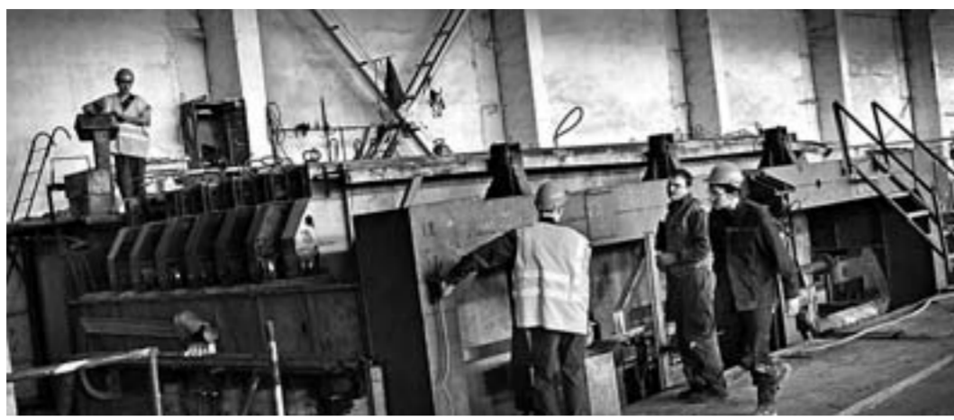
На кассетной установке производится 10 панелей за раз.
