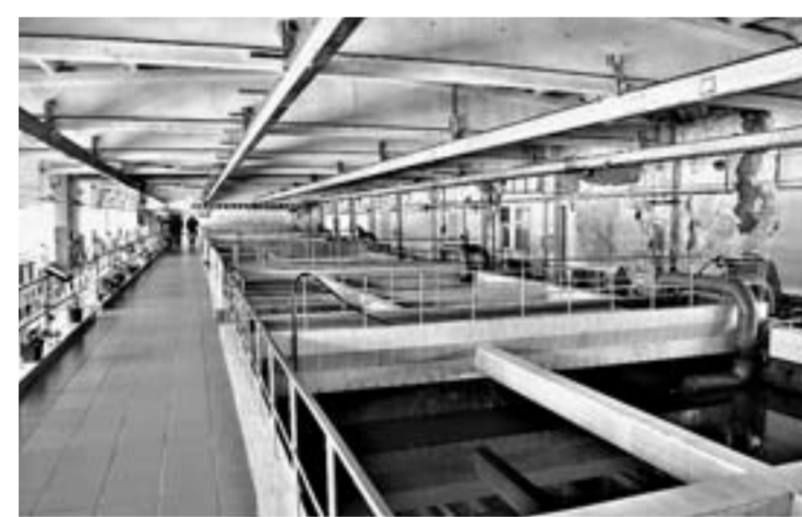
На очистных сооружениях началась подготовка к паводку.
