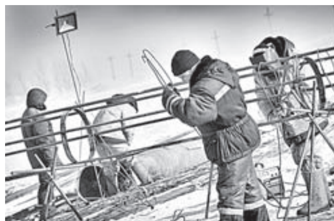
Сварщики готовят каркасы для свай.
