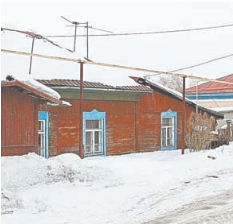
Дом на улице Славгородской, в котором произошла трагедия, сейчас пустует.
