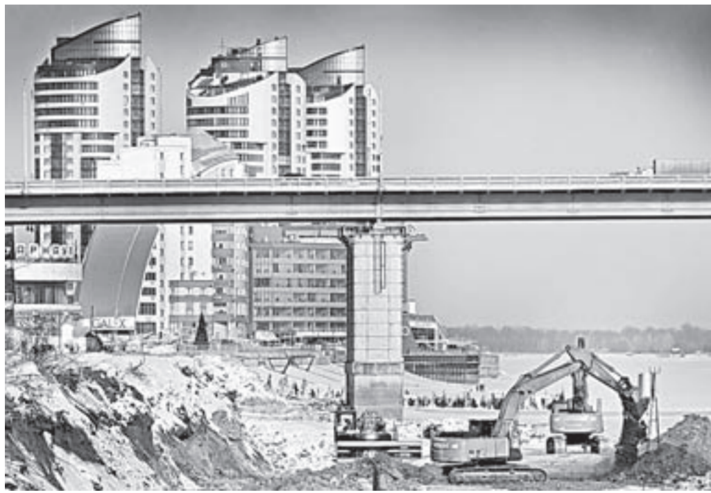
Строительство продвигается от букв «БАРНАУЛ» к мосту.
