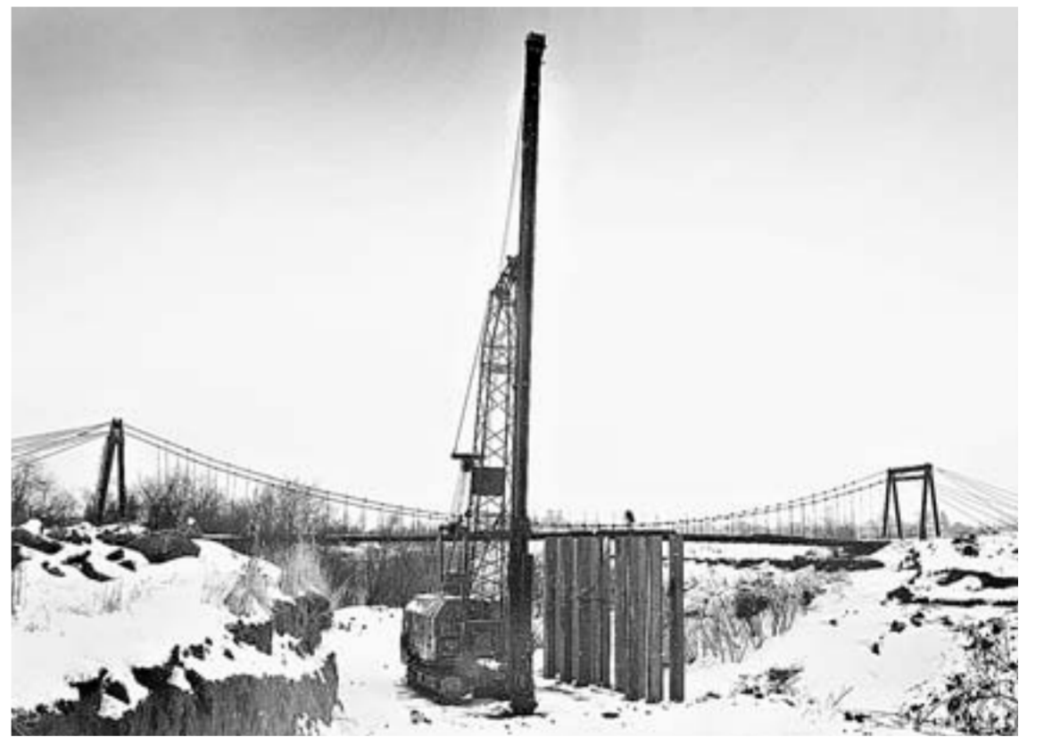
На месте старого будет возведен новый мост из металла и бетона.
