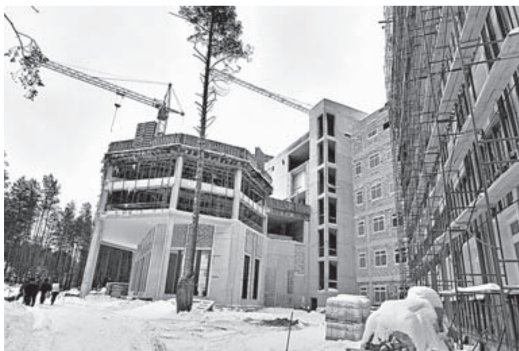
Строительство идет полным ходом.
