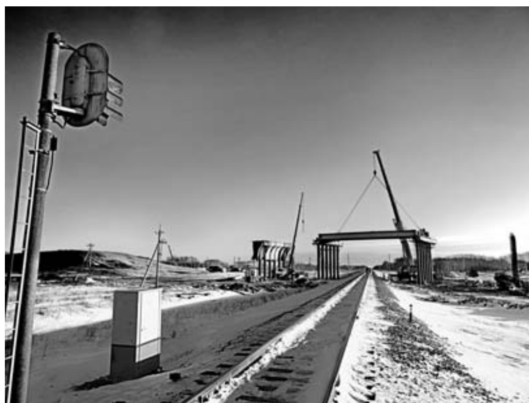
Стройка идет полным ходом.
