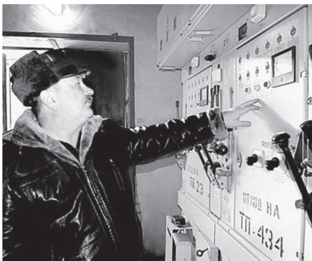
Алексей Черных рассказывает о реконструкции центрального распределительного пункта.
