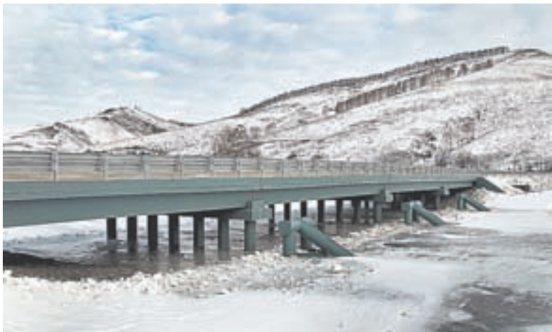
Капитальный мост через реку Ануй.
