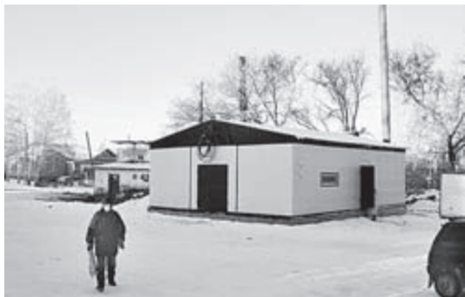
Так выглядят модульные котельные.
