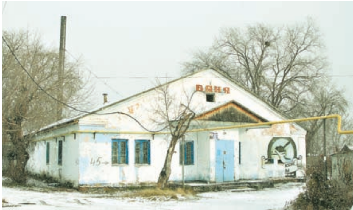
Для кого – баня, а для кого – аварийный объект, требующий капитальной реконструкции.
