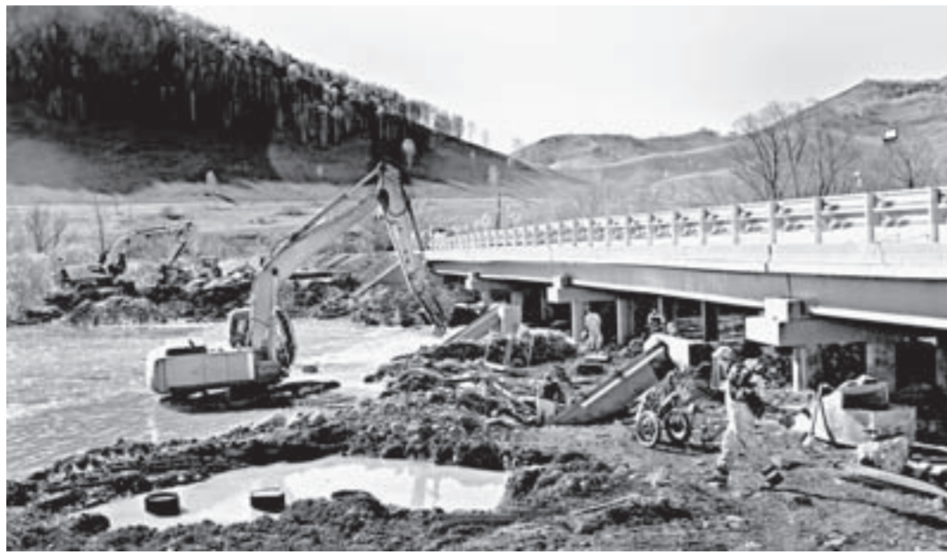
Экскаватор «вплыл» в Ануи и расчищает русло под большим мостом.
