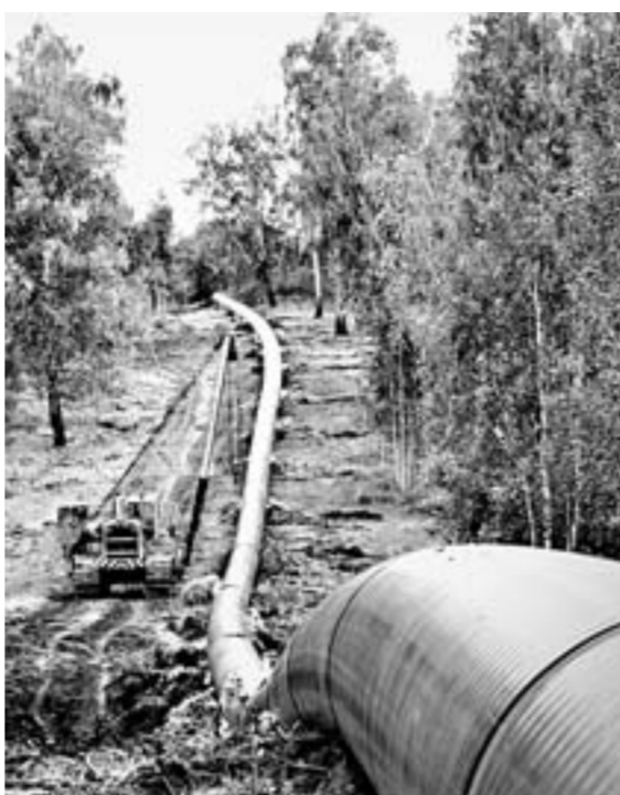
Один из подготовительных этапов проведения ремонтных работ - сварка трубы газопровода в плетть.
