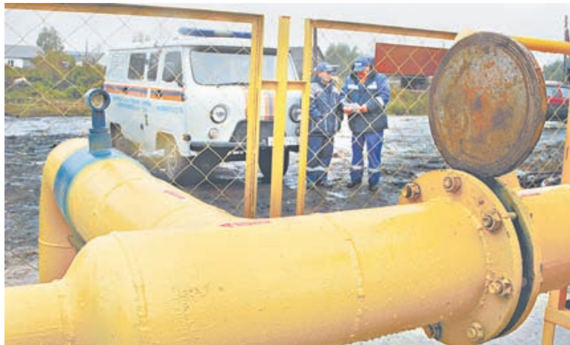
Работы завершены в полном объеме.
