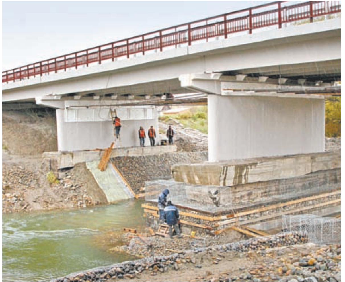
Идет дополнительное укрепление основы.
