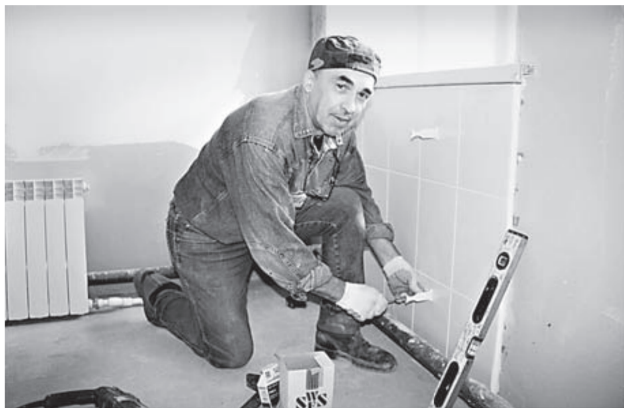
В здании завершается внутренняя отделка.
