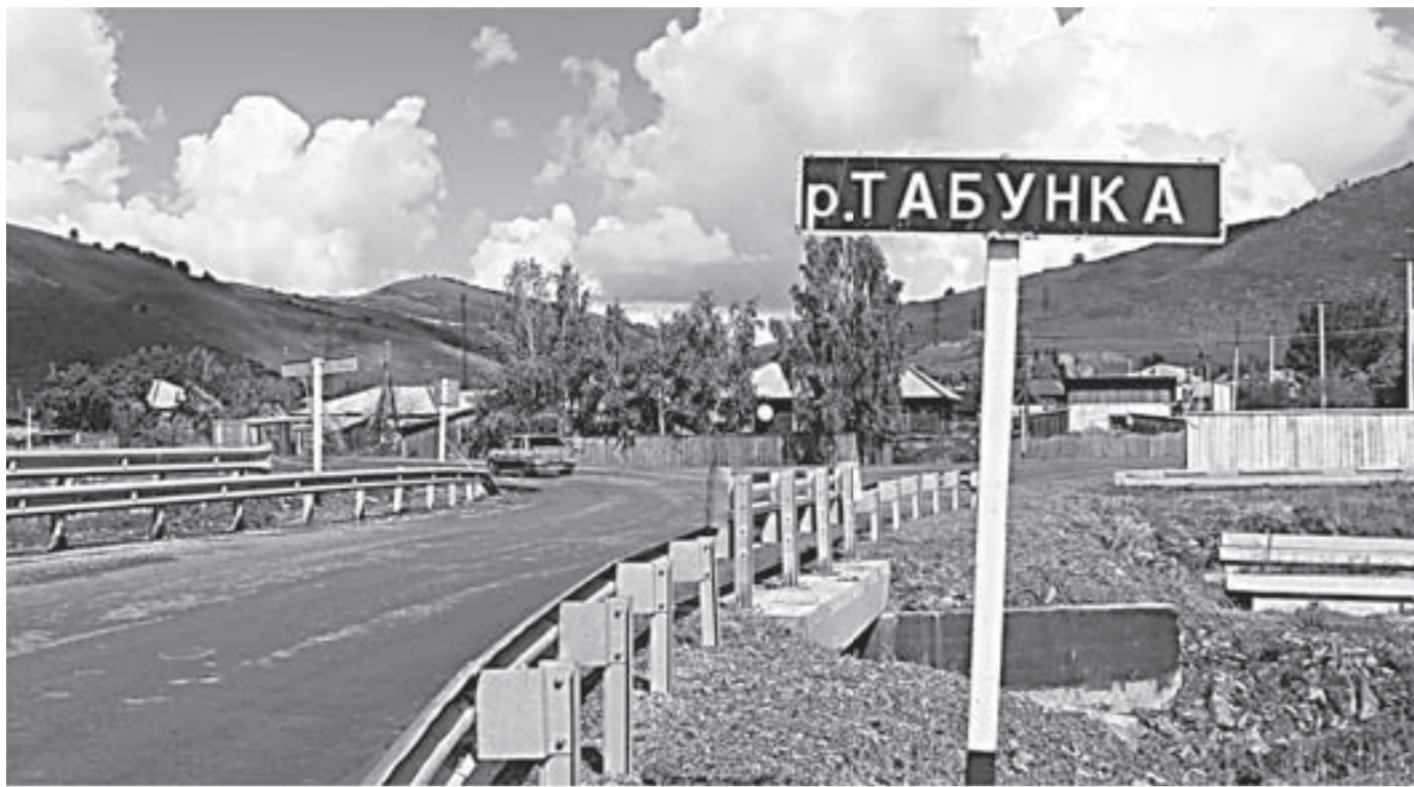
Мост через реку Табунку принципиально важен для жителей: по нему проходит краевая дорога, по которой в район следуют автобусы.
