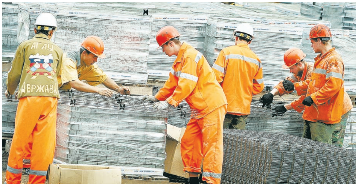
Студенты усердно работают на стройке.
