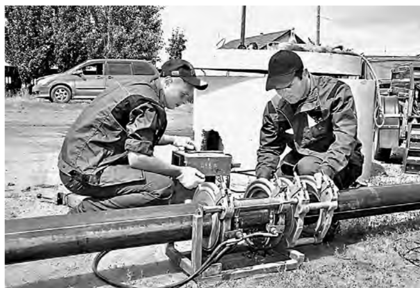
Полиэтиленовая труба удобна при монтаже.
