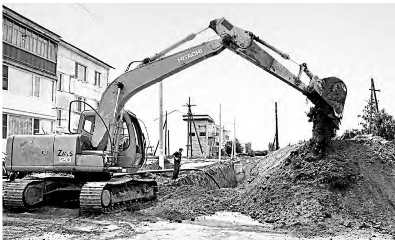
Будет проложено и реконструировано 23 км водопровода.
