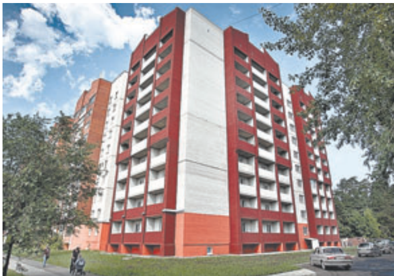
В пятом и шестом подъездах дома вместились 100 однокомнатных квартир.
