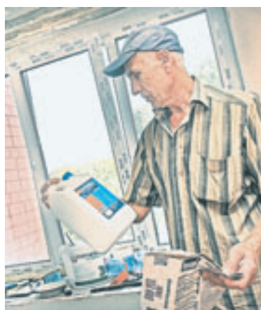
Владимир Бесников ремонтирует квартиру своими силами.
