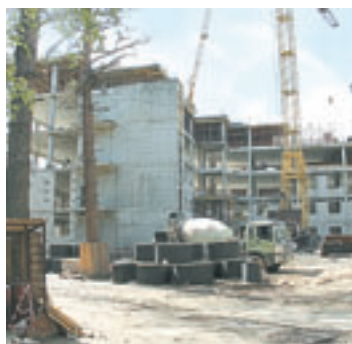
Строительство, полный ход!
