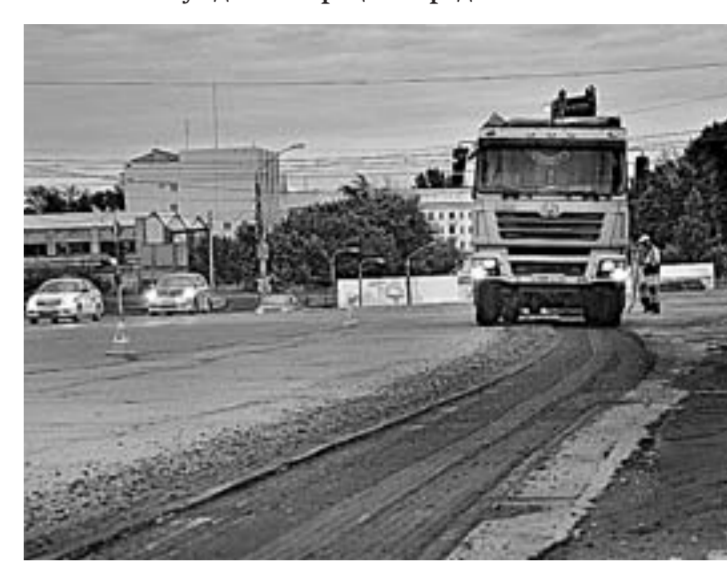
Сумерки ремонту не помеха.
