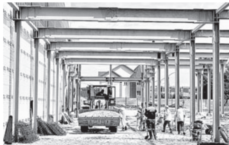
Строители выполнили две трети работ.
