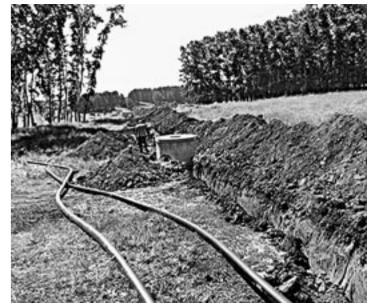
За два года реализации проекта было проложено почти 6,5 километра водопровода к селу Дружба.
